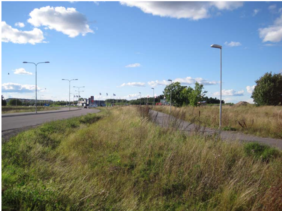
Österleden från sydost. Diket ligger mellan gång- och cykelbanan och gatan.
