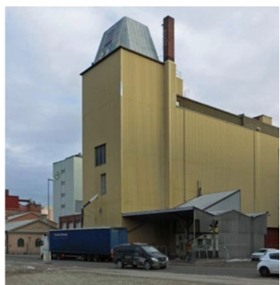
Bild 32 Silobyggnad vid Östra Ågatan
