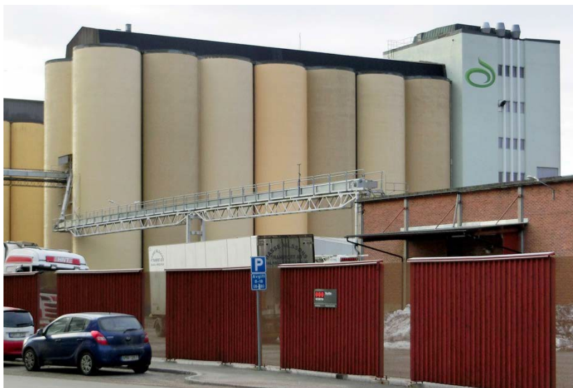
Silobyggnader sett från Ångkvarnsgatan.
