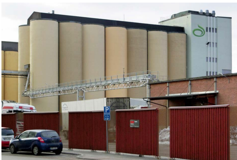
Silobyggnader sett från Ångkvarnsgatan.
