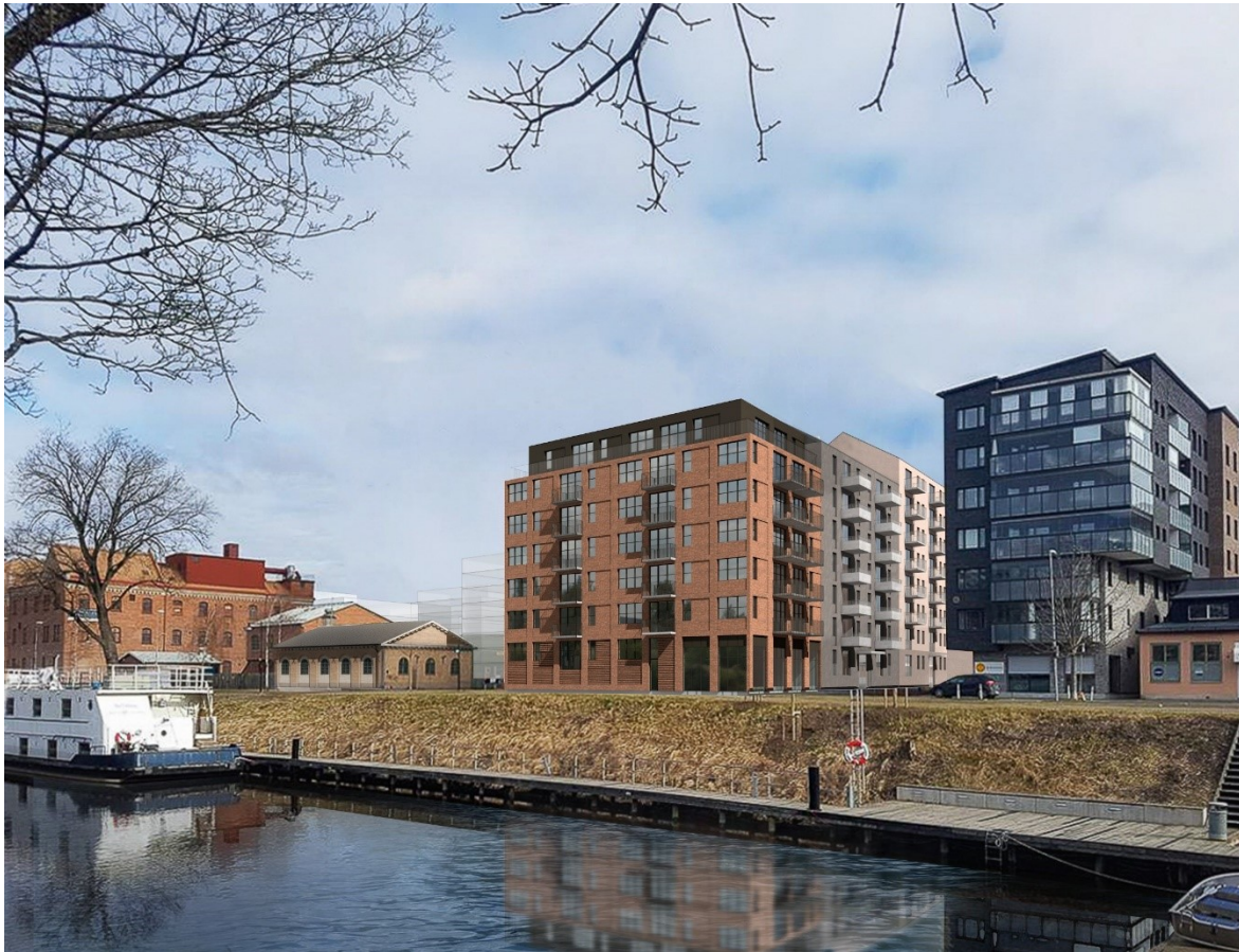
Östra Ågatan med den gamla Pumpstationen samt byggnad D enligt orienteringskartan. Juul Frost Arkitekter.
