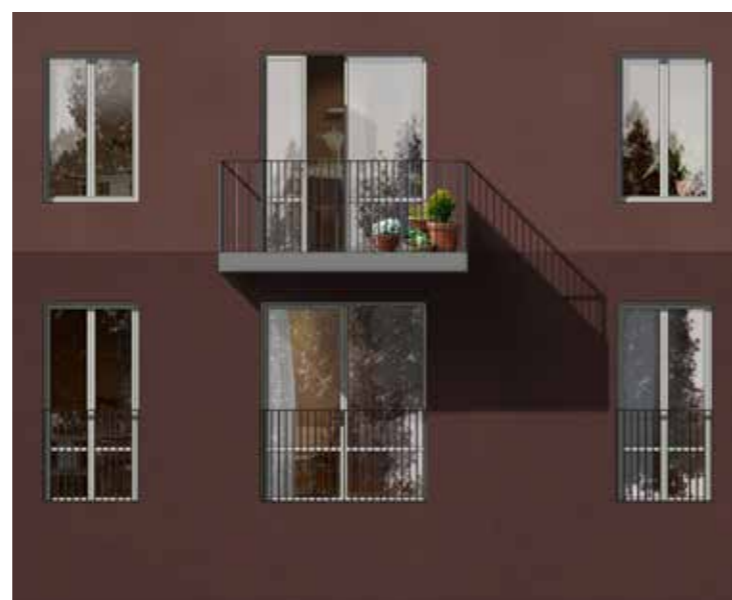
Putsad fasad med sockelvåning i en mörkare nyans än fasaden (B)
