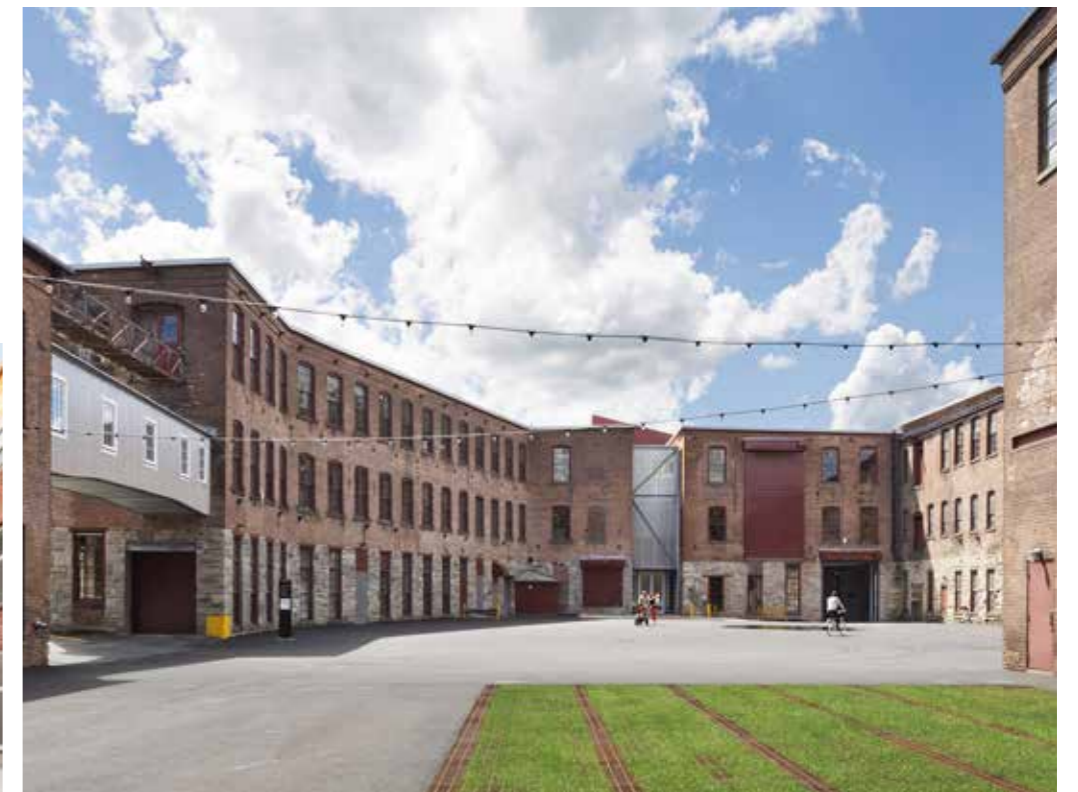
Referensbild: MASS moca building 6, innergård, ombyggnad
