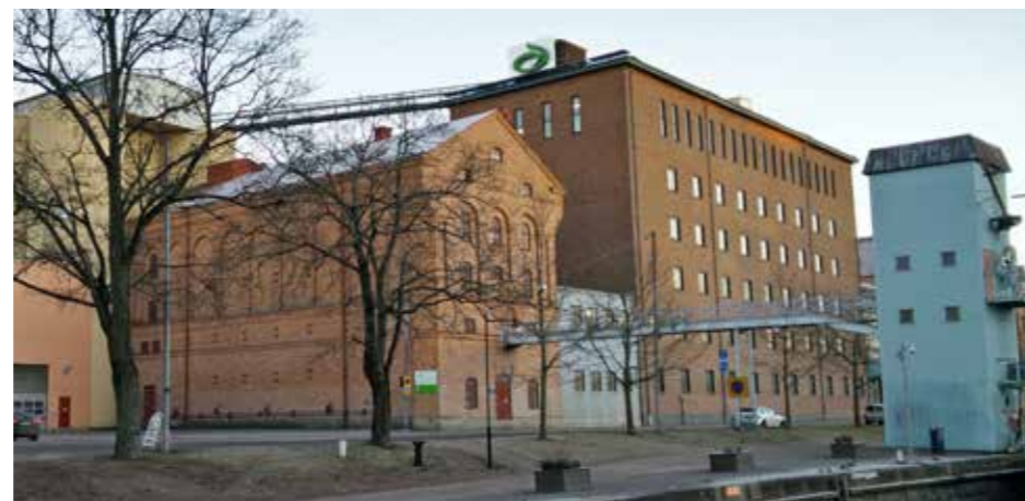
Foto: Norra entrén, Tegelsilon
