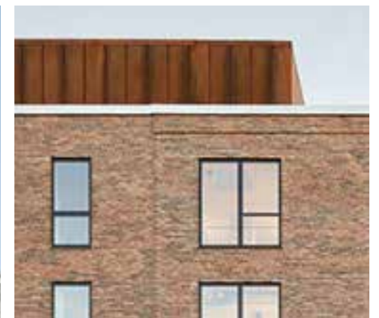
Teknikhus på tak
