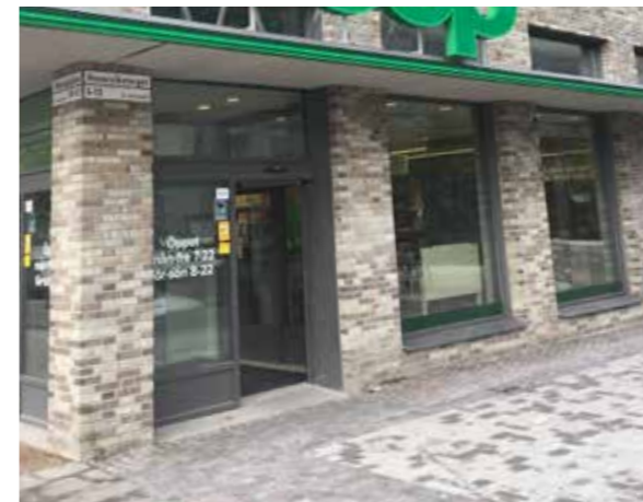
Entré till lokal målad i stål
