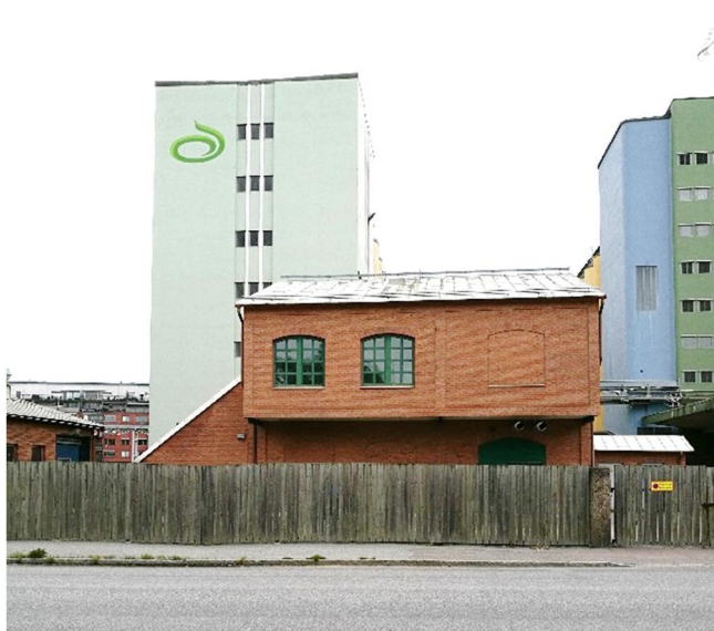
Bild 1. Tullgarns pumpstation med snedställda skruvpumpar på gaveln.
