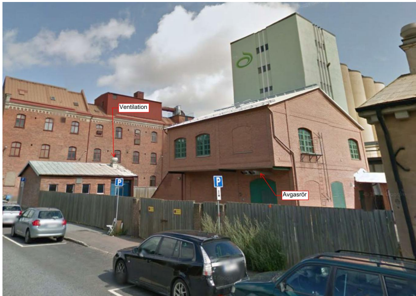
Bild 5. Renshus med ventilationsskorsten till vänster om pumpstationen.
