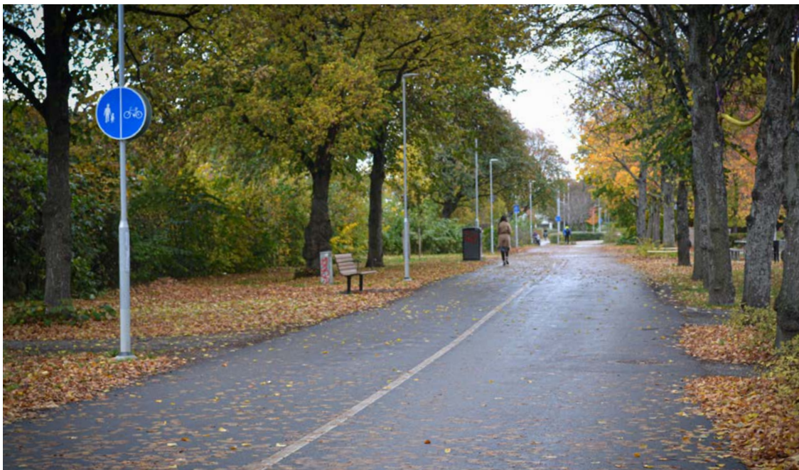
Gränbyleden blev färdigställd 2022. Den nya cykelleden går mellan Kvarntorget, Gränby sportfält och Gränbystaden.
