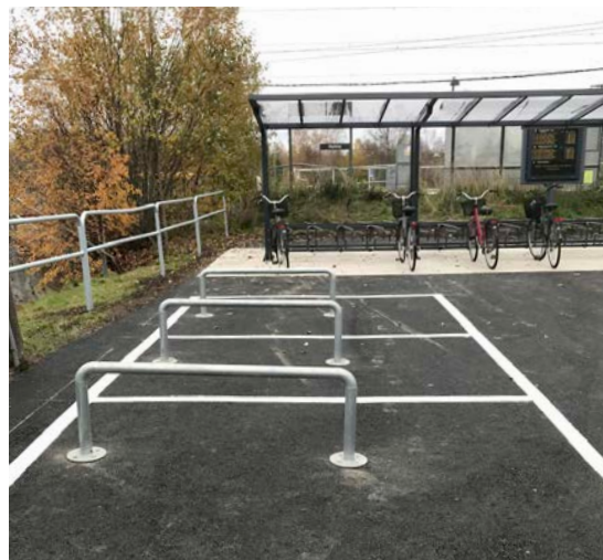
Upprustad cykelparkering intill gamla stationshuset i Skyttorp västra. Cykeltak med plats för 24 cyklar, och 3 lådcykelbågar.
