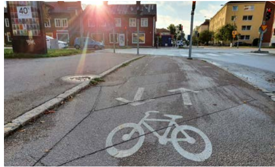
Cykeldetektering utmed Torkelsgatan där slingor i marken känner av att cyklisten närmar sig den signalreglerade korsningen.
