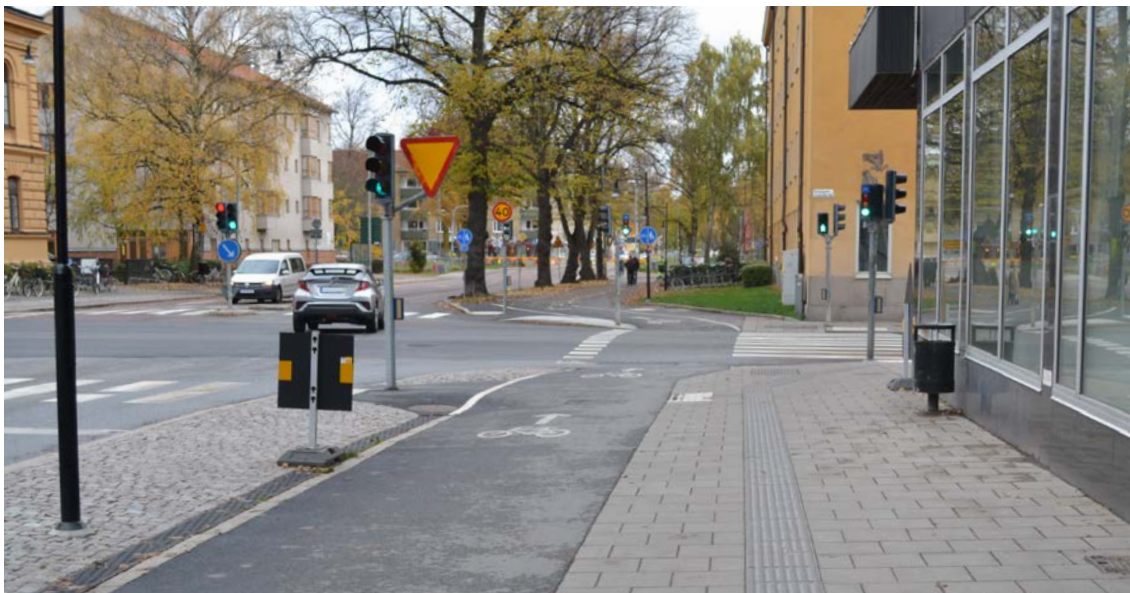
Separering av gång- och cykelbana i korsningen S:t Olofsgatan/Kungsgatan
