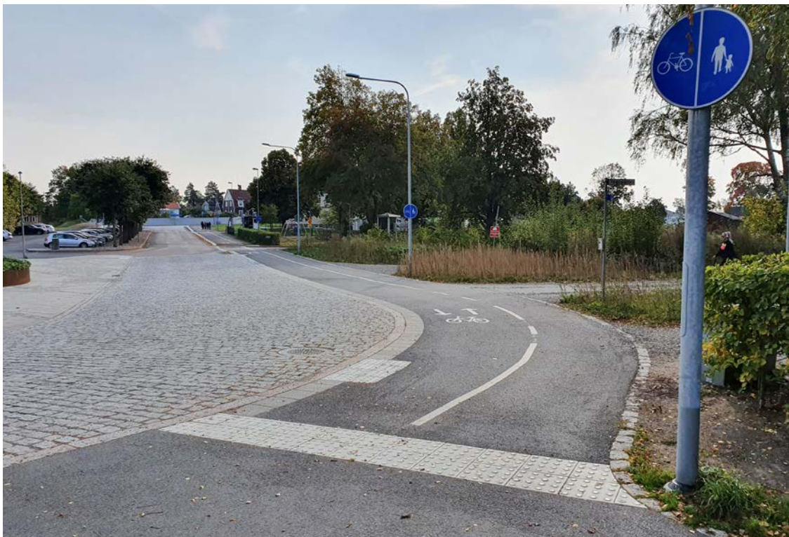
Groaplan i Gamla Uppsala där Uppsala kommun under 2019 minskade körbanans bredd för att inrymma plats för en cykelbana.
