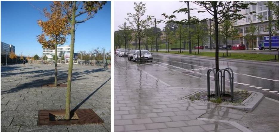
Figur 10. Exempel på trädplanteringar i skelettjordar vid torg och vid gata. Foto: Sweco
