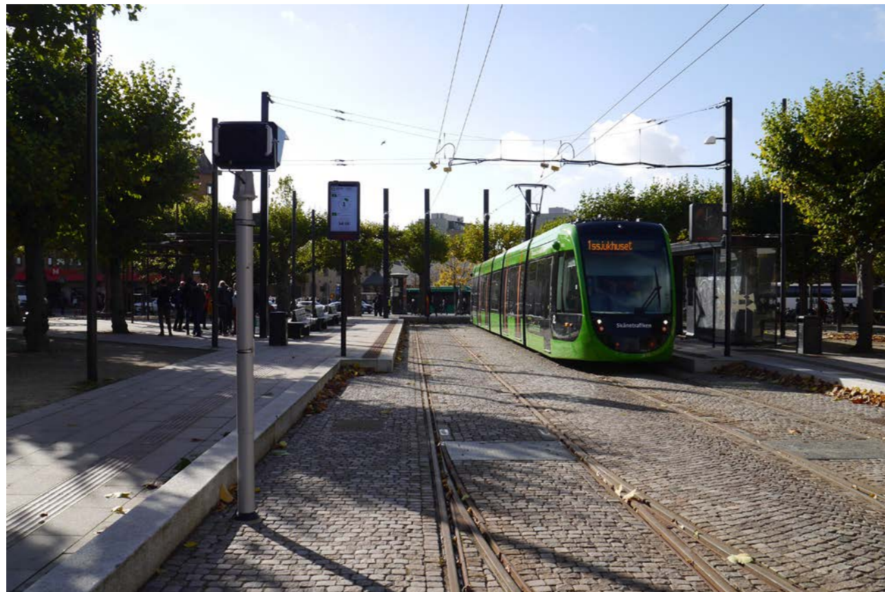
Figur 22. Hållplats på Clemensstorget i Lund där plattformarna ligger i nivå med omgivande torgyta.
