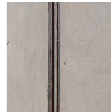
Figur 9. Betong i spår.
