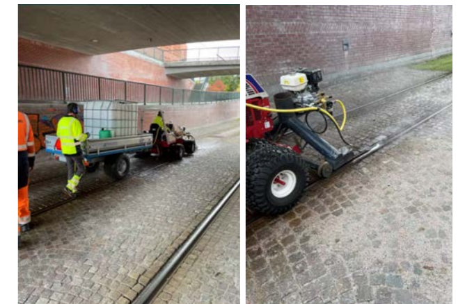
Figur 91. Renhållning av gaturäl i Lund med specialverktyg för högtryckstvätt monterat på skötselfordon. Bildkälla: Roy Haglund, driftsansvarig spårväg Lunds kommun
