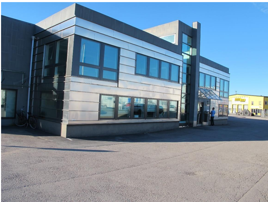
Bild som visar befintlig bebyggelse sett från öst.
