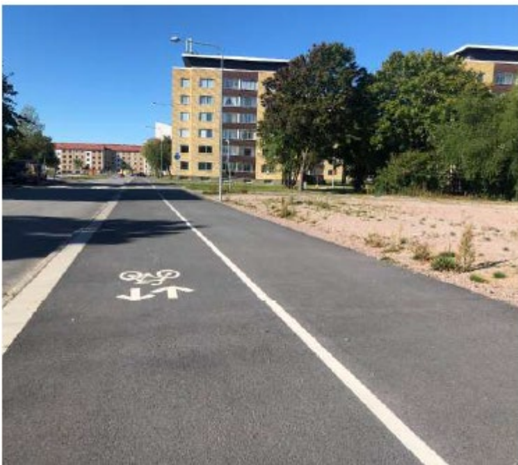
Figur 8. Nybyggd separerad gång- och cykelbana på Sparrisgatan
