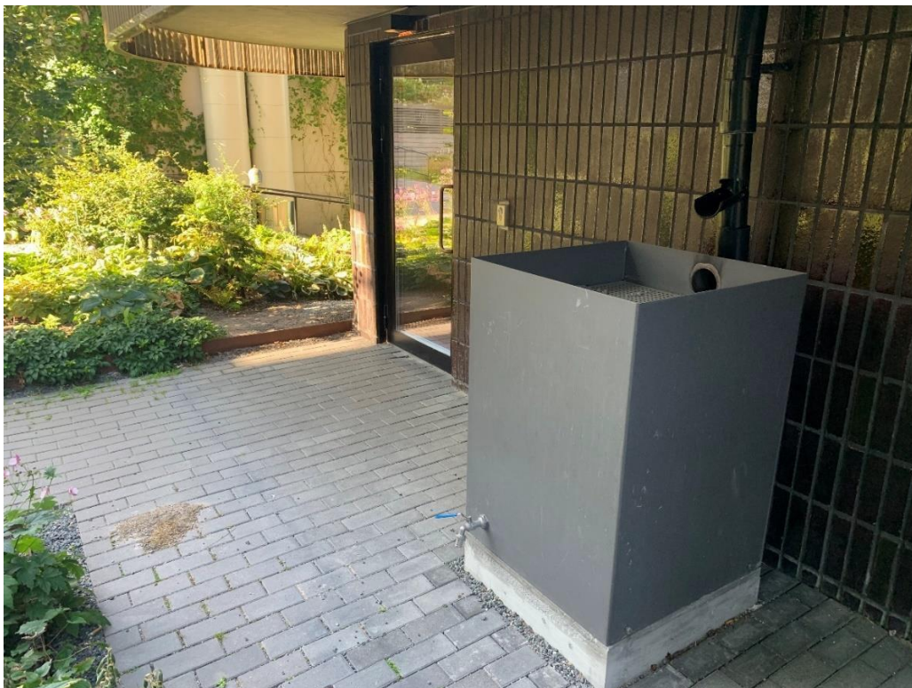
Figur 27. Exempel på stuprör som ansluter till regnskördartunna (Foto: Bjerking AB).
