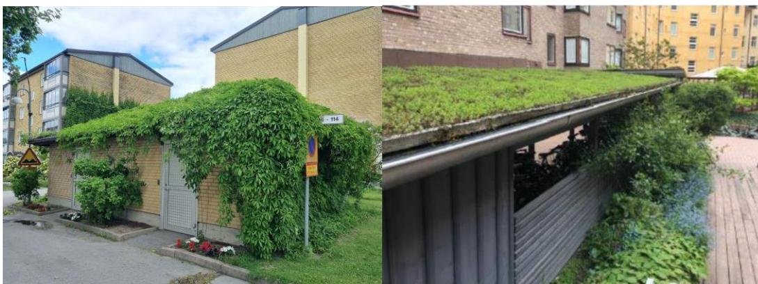
Figur 25. Exempelbilder på gröna tak ovanpå komplementbyggnader. Vid tillfällen då växtligheten och jorden är mättad samlas vatten upp i hängränna för vidare avledning via stuprör. Foton tagna av Bjerking AB.
