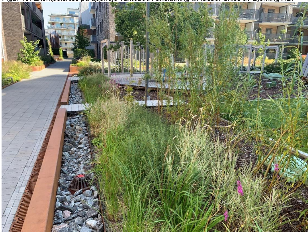
Figur 20. Exempel på upphöjd regnväxtbädd med tät botten (övre) samt nedsänkt regnväxtbädd på bjälklag (nedre). Illustration och bild från Bjerking.
