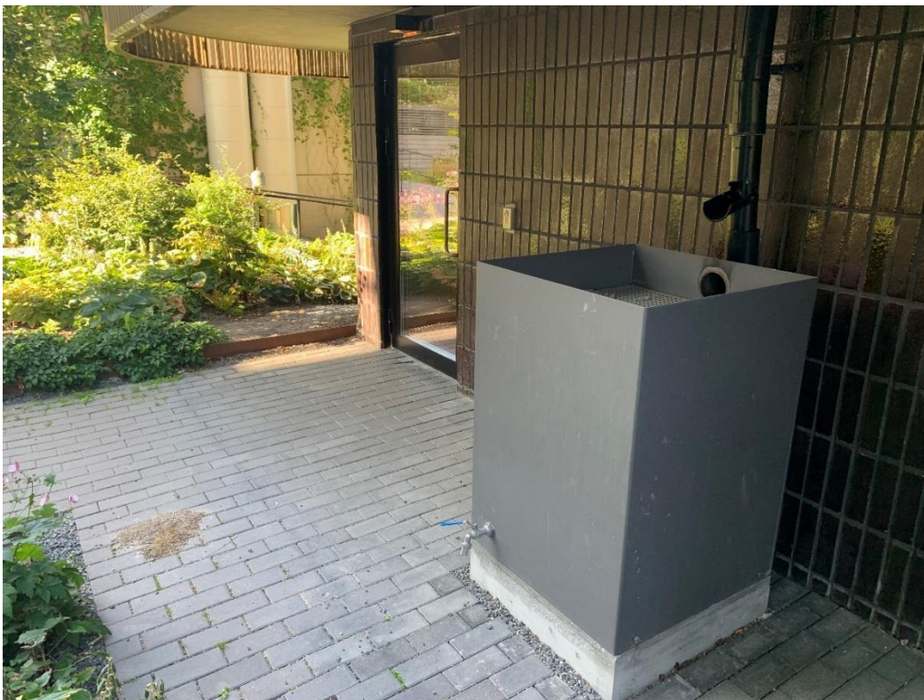
Figur 26. Exempel på stuprör som ansluter till regnskördartunna (Foto: Bjerking AB).
