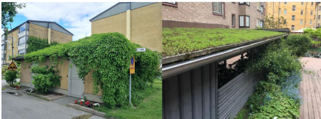
Figur 24. Exempelbilder på gröna tak ovanpå komplementbyggnader. Vid tillfällen då växtligheten och jorden är mättad samlas vatten upp i hänggranna för vidare avledning via stuprör. Foton tagna av Bjerking AB.
