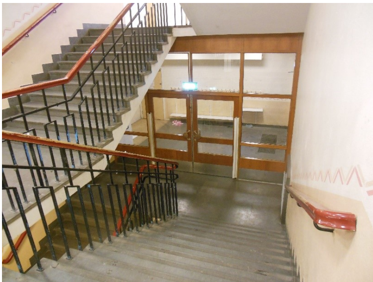
Bilder från trapphusen i den gamla delen av Almtunaskolan. Till vänster ses ett av trapphusen med bevarat träglasparti och trappräcken. Dock är trappräckena förhöjda för att klara modern säkerhetsstandard. Bilden till höger är från invigningsåret 1953.
