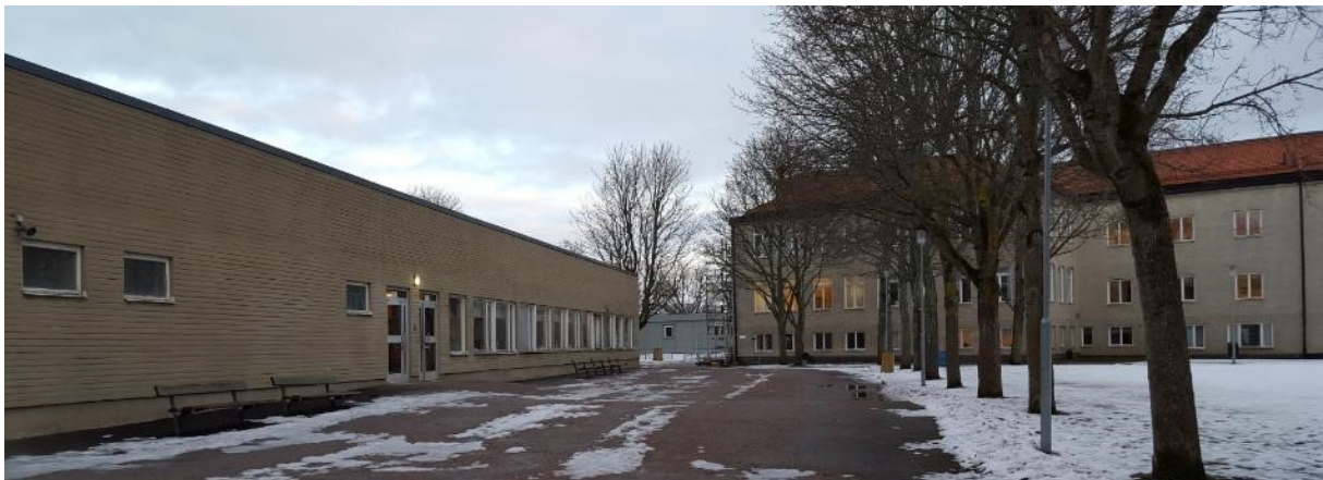
Bild från skolgården, tagen i sydöstlig riktning. Till höger syns östra delen av den gamla Almtunaskolan. Till vänster i bild ligger skolbyggnaden med matsal som uppfördes 1969. I mitten skymtar den tillfälliga modulbyggnaden på Björkgatan. Bilden tagen i februari 2016.
