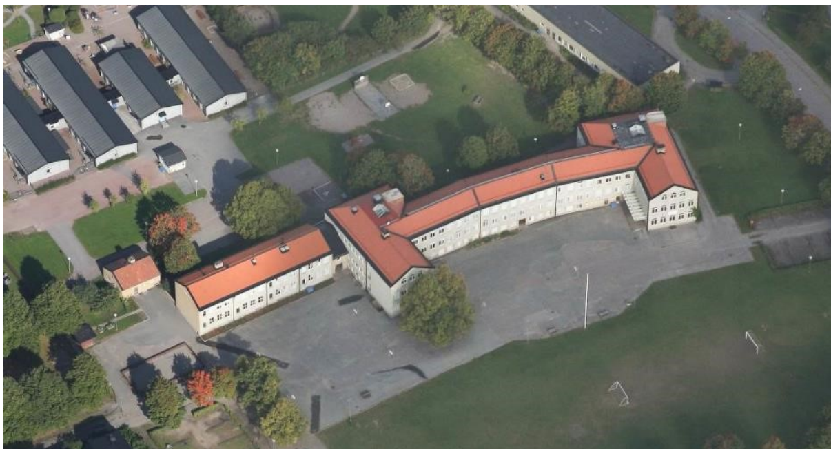
Snedbild från över den äldre delen av Almtunaskolan, södra fasaden (Blom/BlomWEB).
