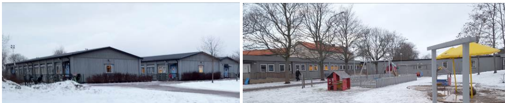
Förskolepaviljonger finns på platsen idag men kommer att försvinna när nya byggnader uppförs.
