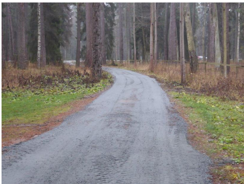
Figur 27 Foto 2 från besiktning innan åtgärder av väg.
