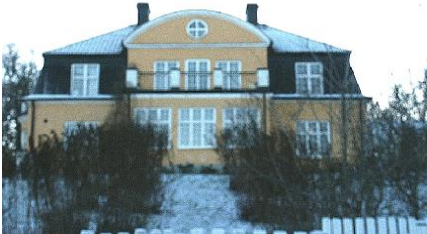
befintlig fd skolbyggnad
