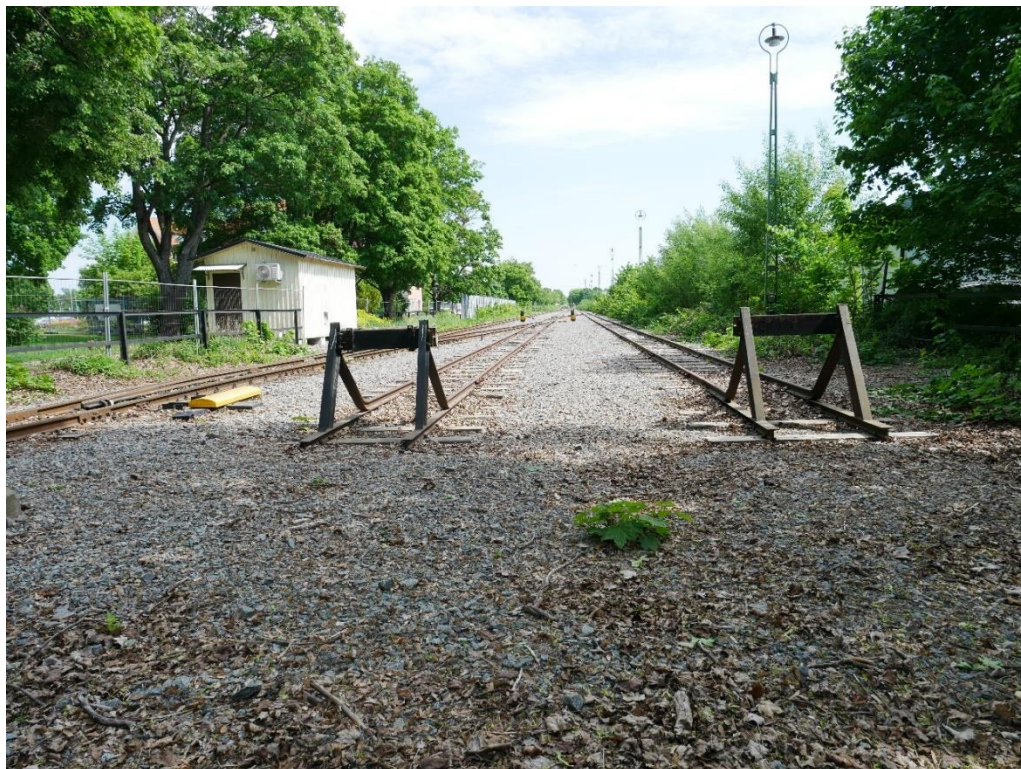
Figur 5. Driftbangårdens spår och teknikhus. Foto taget mot öster.
