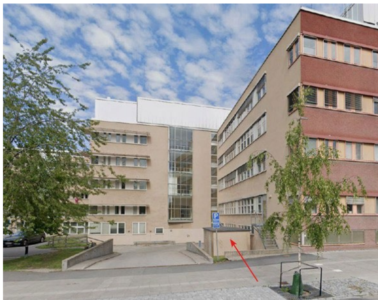
Bild 58 Bild som visar läget för den befintliga elstationen i kvarter B vid Strandbodgatan, Alma arkitekter.
