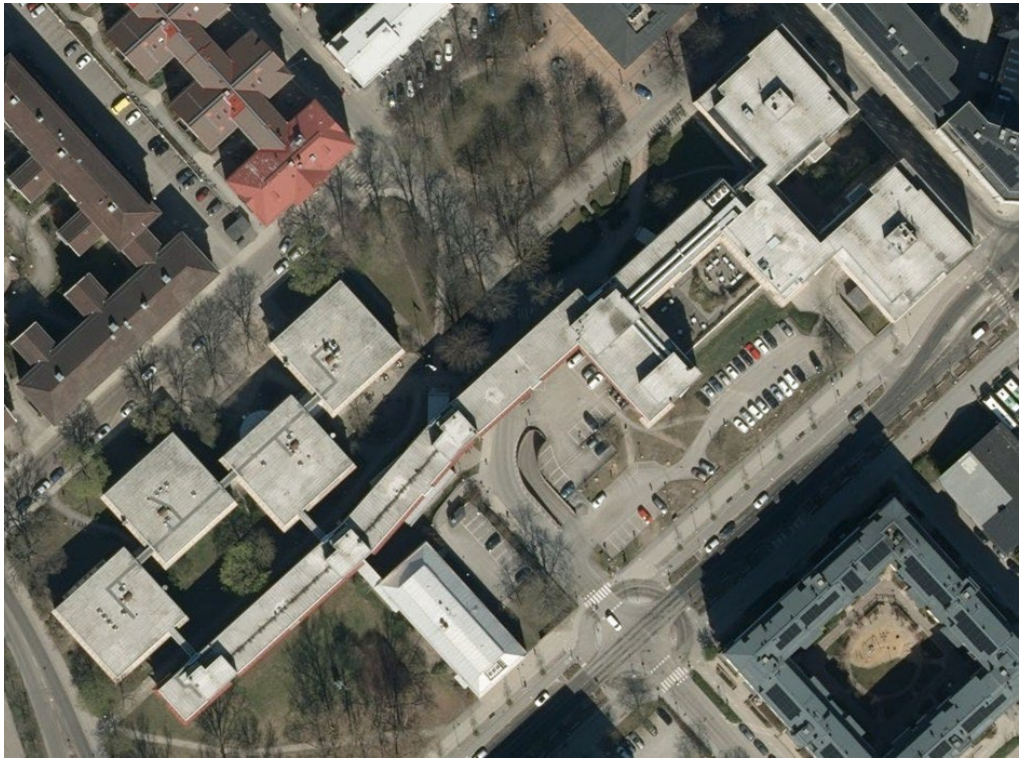
Bild 14 Flygfoto över byggnaderna inom kvarteret Hugin idag.
