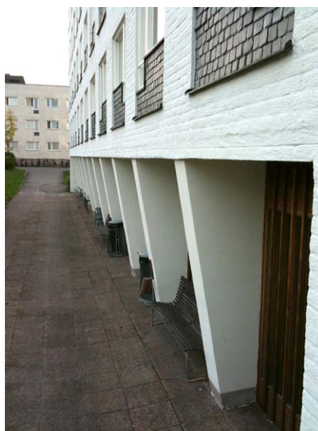
Hus B, souterrängvåning mot söder
