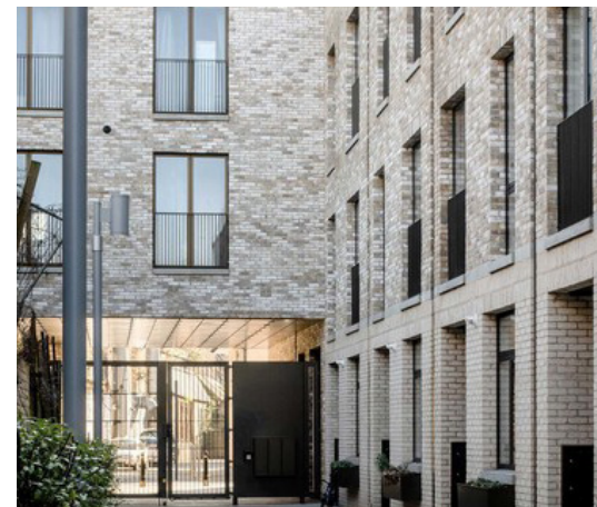
Tegel i olika toner av beige som bryts av med en sockelvåning i en ljusare ton. Karakusevic Carson Architects, London.
