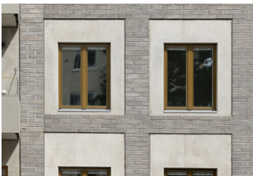
Betongfasad med ett markerat rutnät av liggande tegel. Varg Arkitekter, Kv Stora Sköndal, Stockholm.
