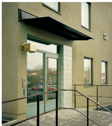
Puts med gröna toner och ett entréparti med inslag av klinker. Marge Arkiteter, Kv Korthällaren Norra, Stockholm. Foto: Johan Fowelin.
