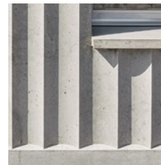
Betong med olika bearbetningar
