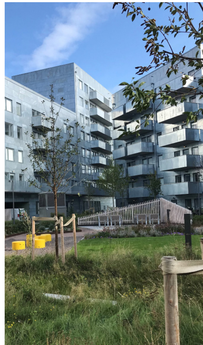
Fasader och delar av balkonger i zink. Kvarteret Knäckepilen, etapp 1.
