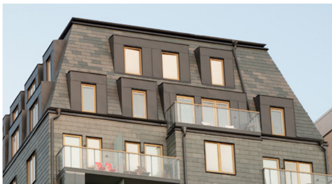
Sadeltak med ett takfall i två våningar. Varg Arkitekter. Foto: Mikael Olsson.
