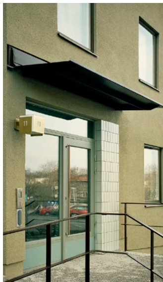
Entréparti med inslag av klinker och skärmtak mot en putsad fasad. Marge arkitekter, Kv Korthällaren Norra, Stockholm. Foto: Johan Fowelin.
