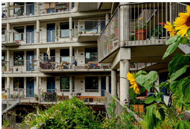
Loftgångar utformade med utrymme för umgänge och möten. Kanozi Arkitekter, Kvarteret Trevnaden, Malmö. Foto: Werner Nystrand.
