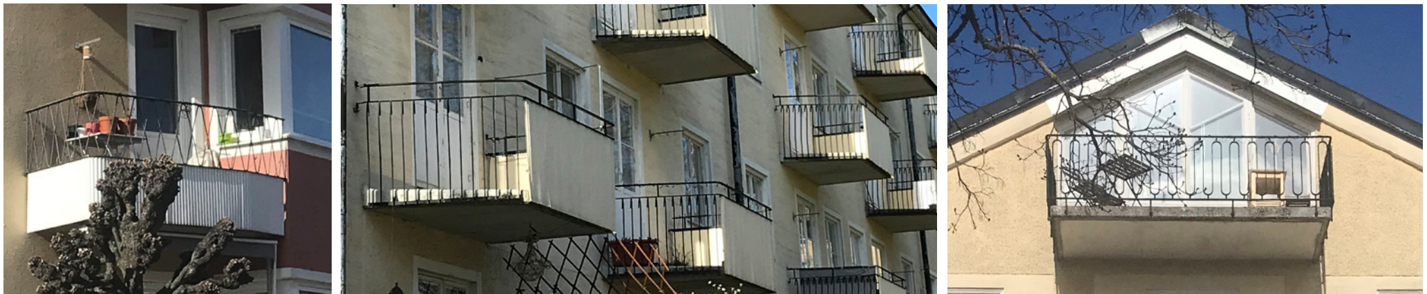
Många balkongräcken i Sala backe utgörs av smidesräcken eller korrugerad plåt. Det finns även många exempel på när dessa kombineras.
