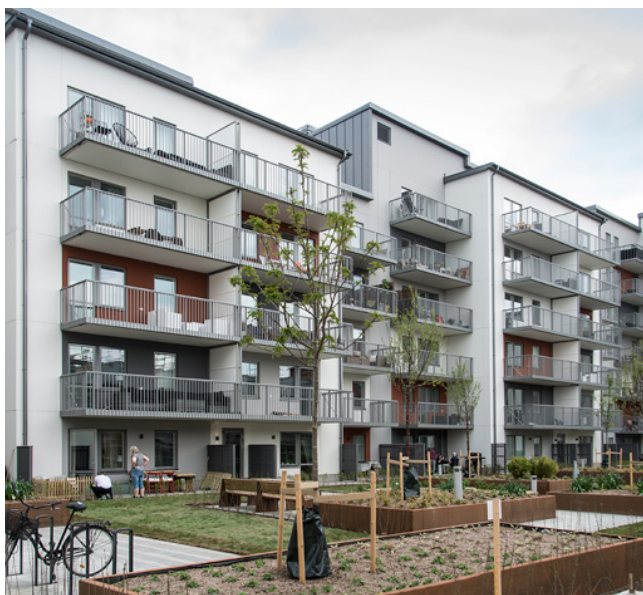
Vitputsad fasad med inslag av röda och gråa fasadpartier. Kvarteret Nattviolen, etapp 2.
