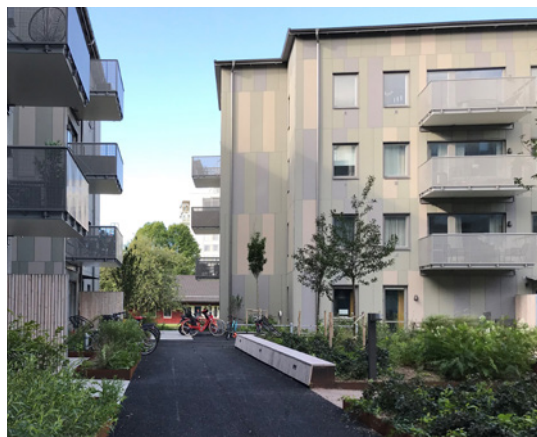
Fasader av skivmaterial olika ljusa kulörer som skapar mönster. Kvarteret Knäckepilen, etapp 1.
