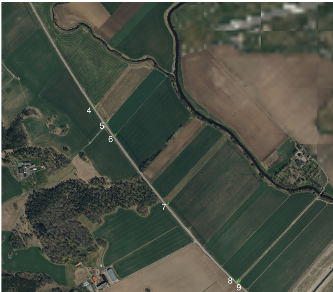
Figur 9. Dike 4, 5 och 9 bedöms utgöras av biotopskyddade diken bredvid väg 272. Dikena är i regel mycket längre än den gröna linjen indikerar, endast den bit som är i direkt anslutning till planerad GC-väg har markerats.
