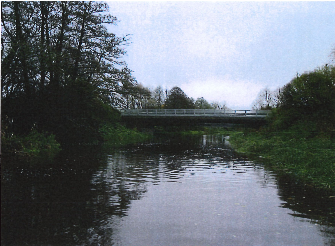
Foto 2. Lokal nedströms i Fyrisån, Uppsala, sydostlig riktning.
