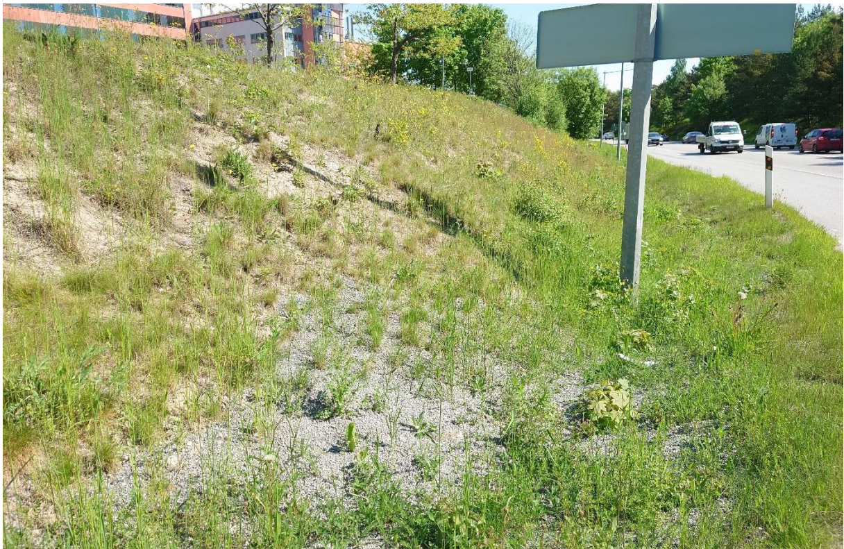
Figur 1. Solbelyst vägkant norr om Kungsängsleden.
