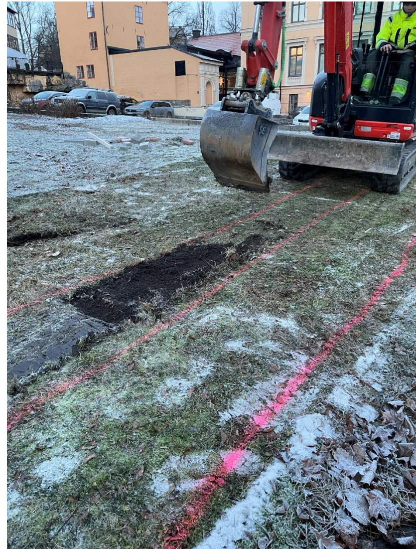
Gräs och övre jordlager avlägsnas med grävmaskin
