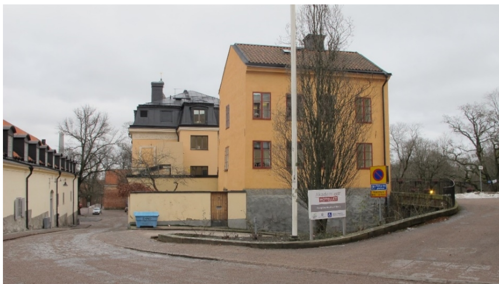
Foto som visar "Stenhuset" sett från Åsgränd.
