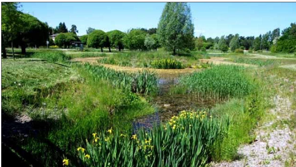
Figur 2-9 Exempel på en god utformad dagvattendamm (Dagvattenguiden, 2017)
