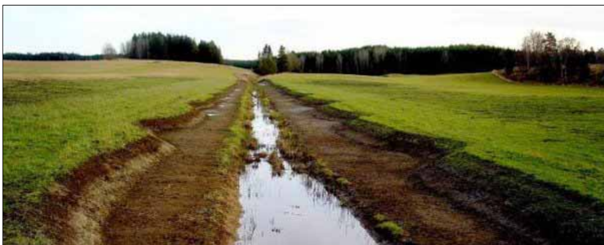
Figur 2-13 Exempel på anlägg av ett tvåstegsdike (Jordbruksverket, 2013)
