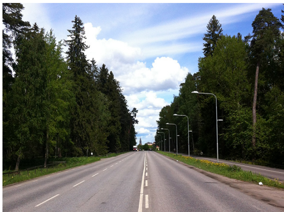
Dag Hammarskjölds väg söderifrån med planområdet till höger i bild.
