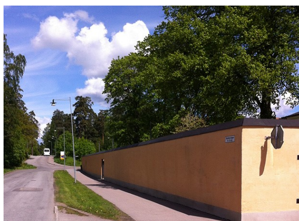
Muren (del av Asylen, Kronåsen 5:4) längs östra sidan av Ulleråkersvägen i höjd med planområdet.
