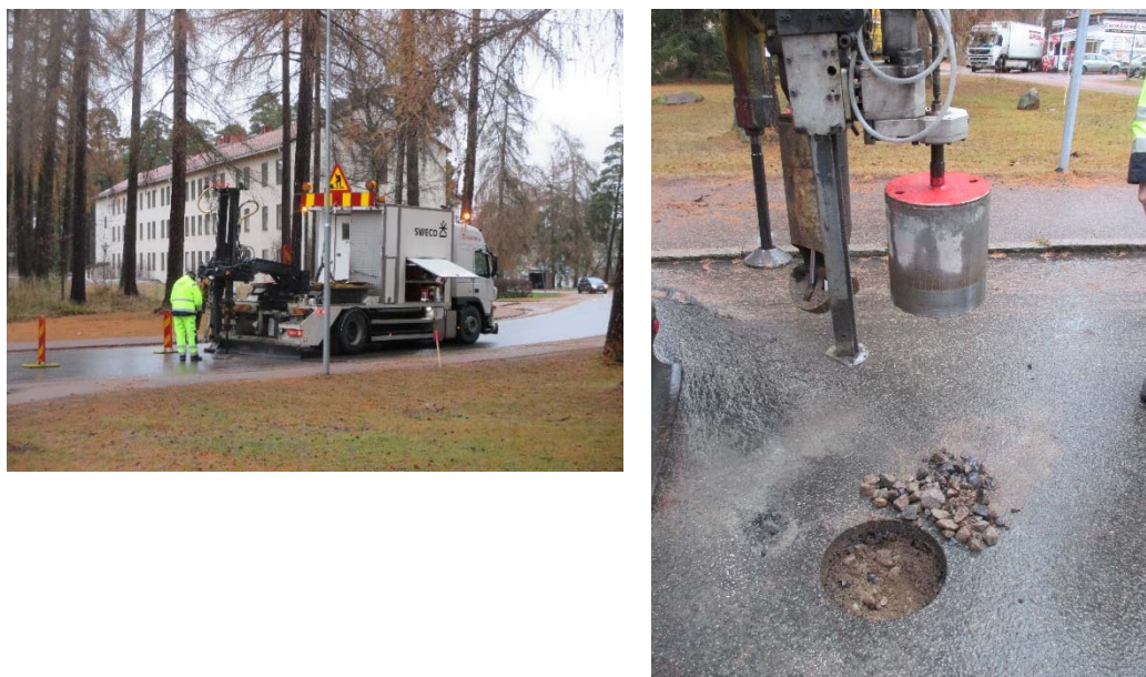
Figur 5: Asfaltsprovtagning med provtagningsbilen "Underlättaren".
