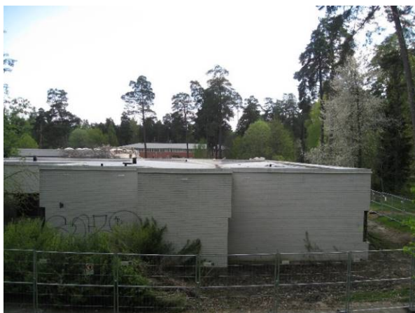
Figur 2.4.2. Byggnad 78 Neurologiskt centrum innan rivning
