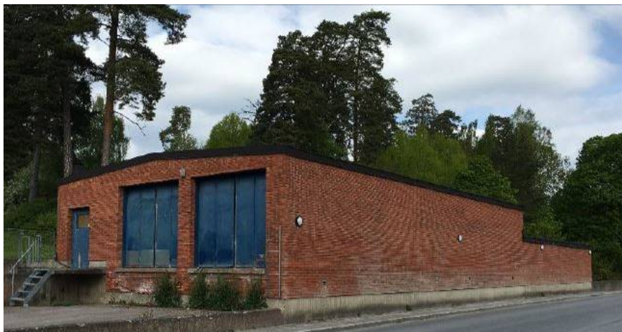
Figur 4.5.6 Byggnad för tvätthantering invid Ulleråkersvägen (hus nr 76) innan rivning
