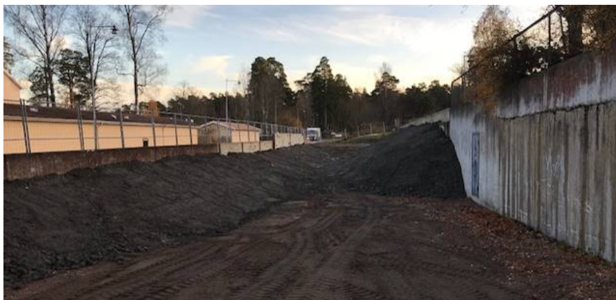
Figur 4.5.7 Byggnad för tvätthantering invid Ulleråkersvägen (hus nr 76) efter rivning
