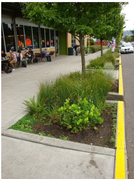
Figur 12: Exempel på växtbädd i gatumiljö dit dagvattnet leds. De 90-gradiga vinklarna för inloppet gör att allt vatten inte når växtbädden vilket var tanken. Exemplet är från Portland i USA
