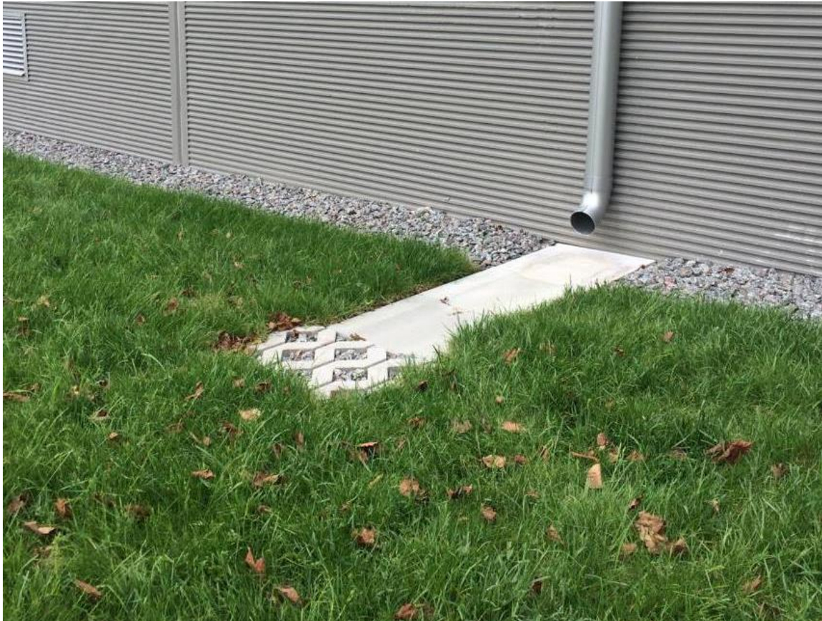
Figur 5-2. Stuprörsutkastare leder dagvattnet via en betongränndal ut mot intilliggande gräsyta. Foto av Structor Uppsala AB.
