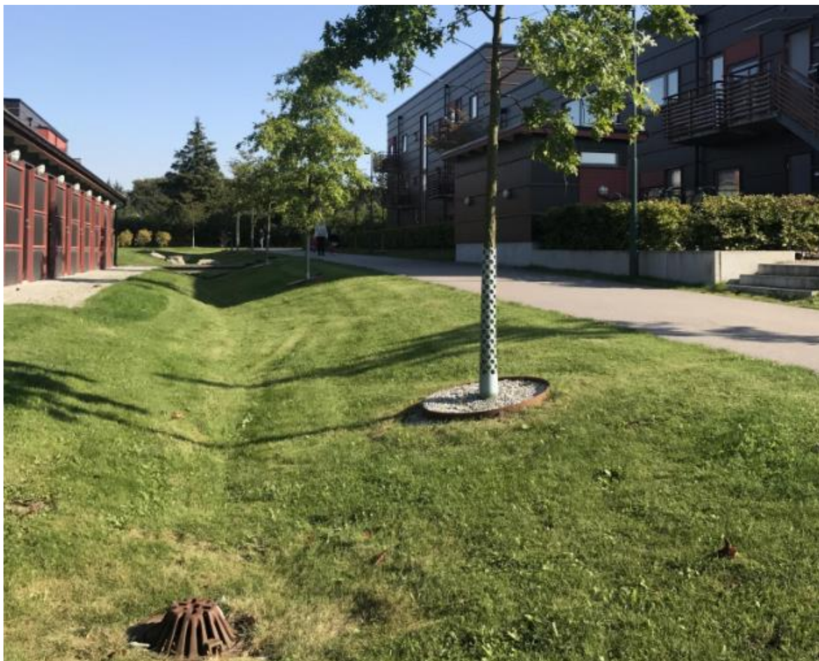
Figur 5-4. Ett svackdike i ett bostadsområde i Malmö. Foto: Structor Uppsala AB.
