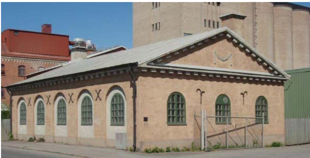
Pumpstationen ritad av Leche (foto B. Ringström 2008)
