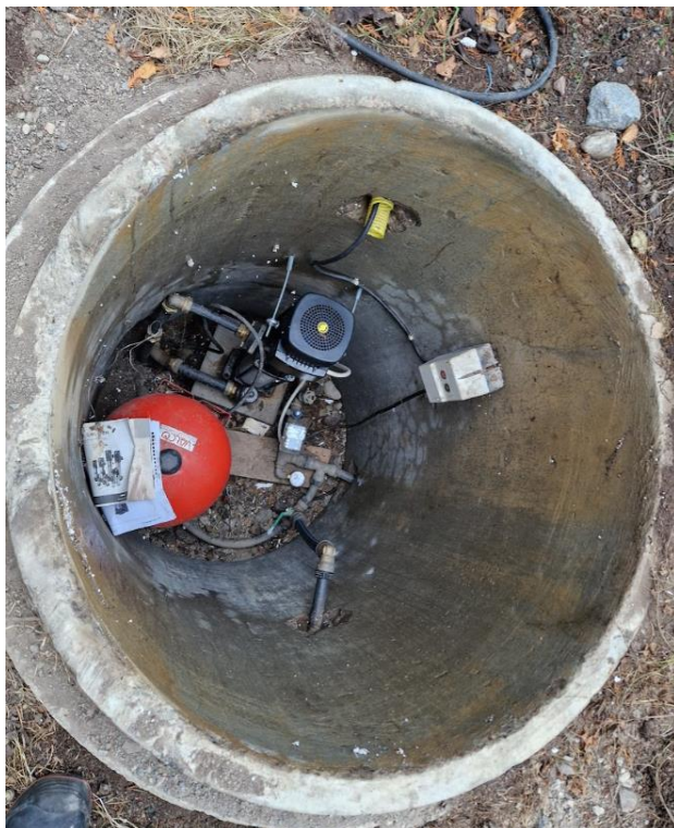
Figur 3-1. T.v. Pumpbrunnen i bilden till höger där hydropressen och pumpen finns. Från cementringen går en PEM-slang till botten och kranen (bilden till höger). T.h. Kran med ventil för att öppna och stänga som de såg ut innan installation av flödesmätare och konduktivitetsmätare. Det utpumpade vattnet kommer in till höger i bild och går i en loop förbi flödesmätaren innan det fortsätter till stenkistan under däckhögen.
