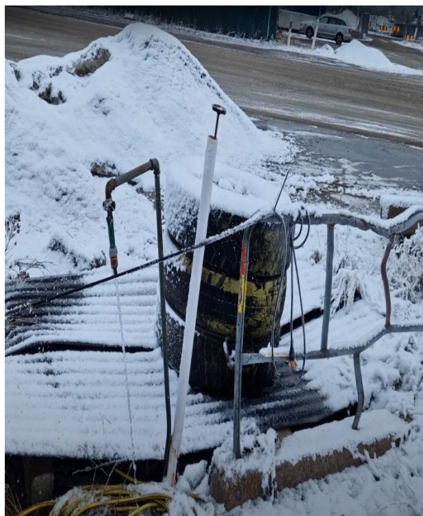
Figur 3-1. T.v. Pumpbrunnen i bilden till höger där hydropressen och pumpen finns. Från cementringen går en PEM-slang till botten och kranen (bilden till höger). T.h. Kran med ventil för att öppna och stänga som de såg ut innan installation av flödesmätare och konduktivitetsmätare. Det utpumpade vattnet kommer in till höger i bild och går i en loop förbi flödesmätaren innan det fortsätter till stenkistan under däckhögen.
