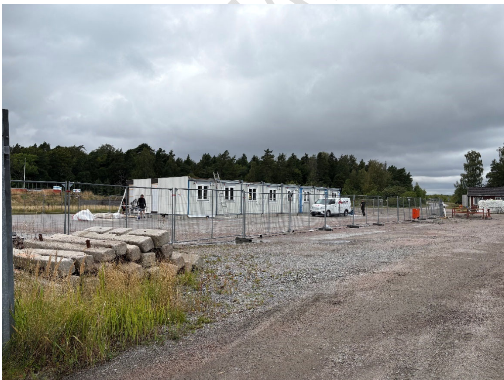
Figur 6 Byggbodar under uppbyggnad. Dessa ersätter tidigare nedbrunnen byggnad i samma läge.
