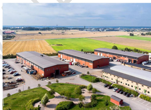
Figur 17 Verksamhetslokaler i Vaksala-Eke med röda fasader i skivmaterial tak i svart papp. Foto: LLENTAB.
