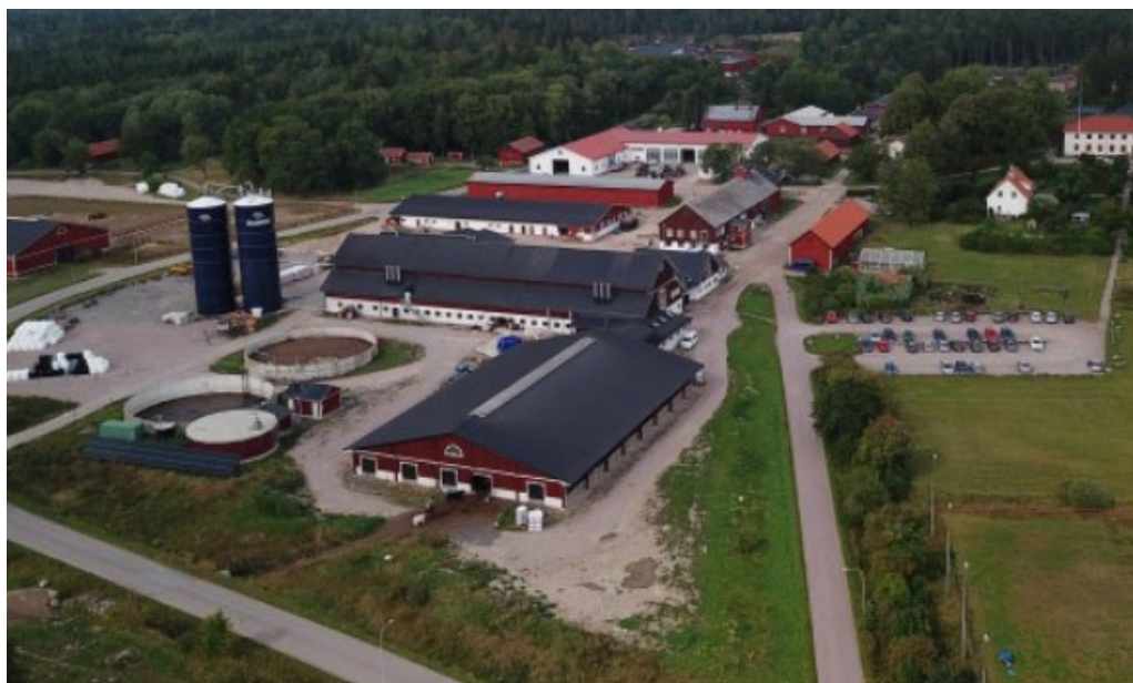
Figur 15 Lantbruksbebyggelse i Jälla med fasader i en blandning av rött trä och vit puts. Foto: Uppsala kommun.
