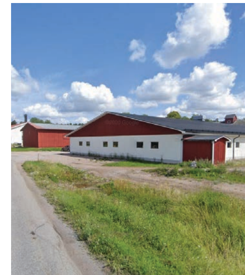
Flerbostadshus i Vaksala-Vallby (vänster) & lantbruksbyggnader i Jälla (höger). Foton från Google Maps
