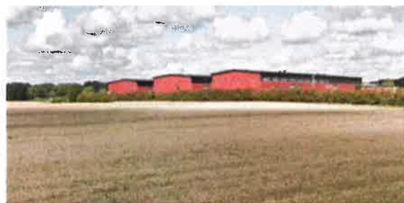
Ex. på storskalig bebyggelse i närområdet. Bild tagen från väg 288 norrut.
