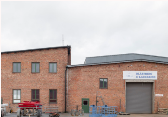
Verksamhetsbyggnad i Vaksala-Eke (nedan). Foto från Google Maps
