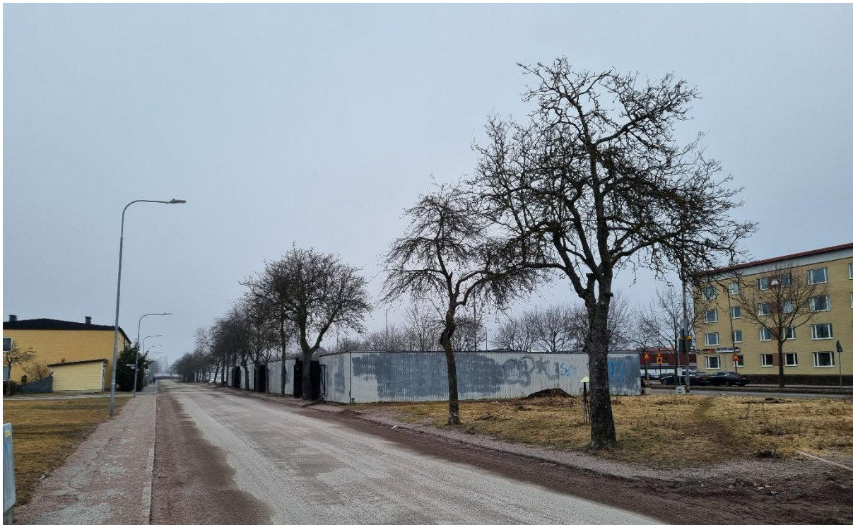
Figur 6. Allé längs Gärdets Bilgata. En del av träden är skadade.
