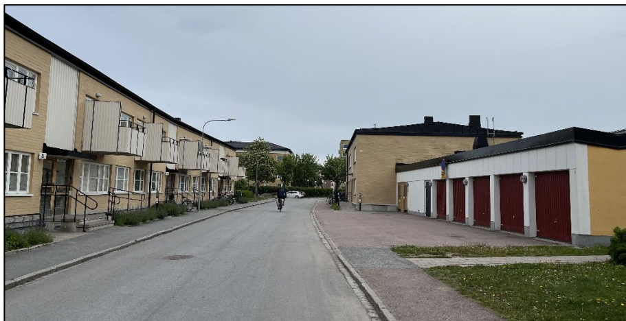
Figur 23 Foto som visar Kvarngärdets typiska bostadsbebyggelse. Till höger ses en byggnad för parkering och tvättstuga, funktioner som integrerats i de flesta av områdets kvarter. I fonden av gatan ses Vaksalagatans träd och högre flerbostadshus.
