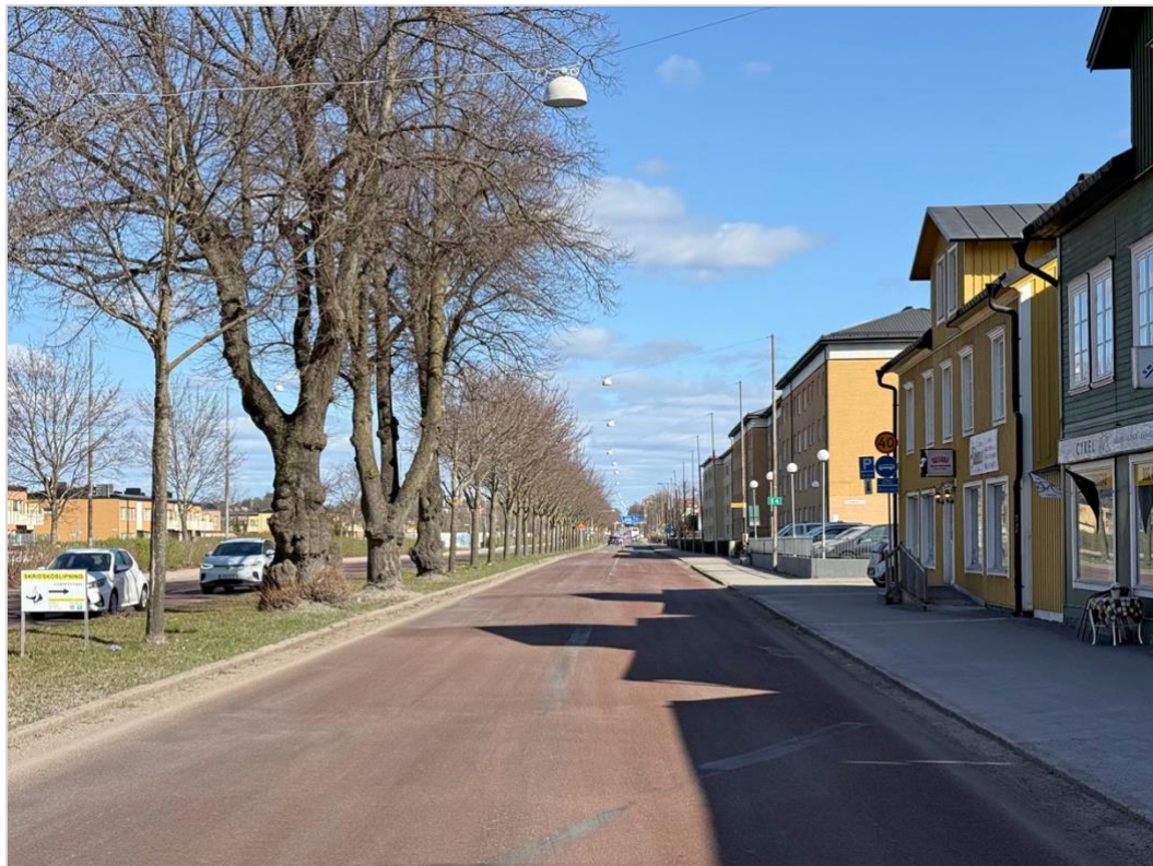
Vaksalagatans ursprungliga sträckning som den upplevs idag. Den tidigare dubbelsidiga allén har blivit en enkel trädrad mellan de numera dubbla körfälten. Breddningen av gatan gjordes samtidigt som utbyggnaden av Kvarngärdet och anläggandet av Tycho Hedéns väg under 1960-talet. Den södra sidan av allén är borta sedan länge (jämför med bilden på sidan 7).
