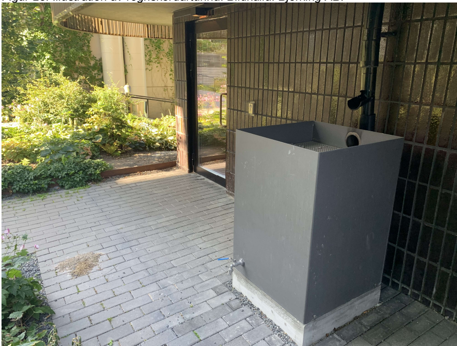
Figur 24. Exempel på stuprör som ansluter till regnskördartunna. Foto: Bjerking AB.
