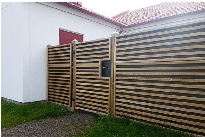
Figur 7. Exempel på bullerplank med dörr
