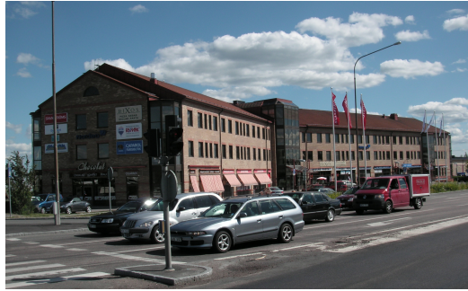
Kontorsfastighet vid korsningen Stålgatan – Bolandsgatan.
