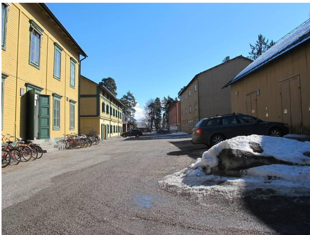
Foto som visar den förrådgata som ligger inom byggnadsminnet Uppsala hälsobrunn och Eklundshof sedd från nordväst.
