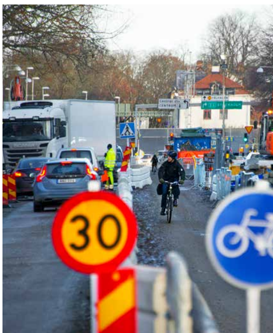
Exempel på trafikomledning vid pågående gatuombyggnad.
