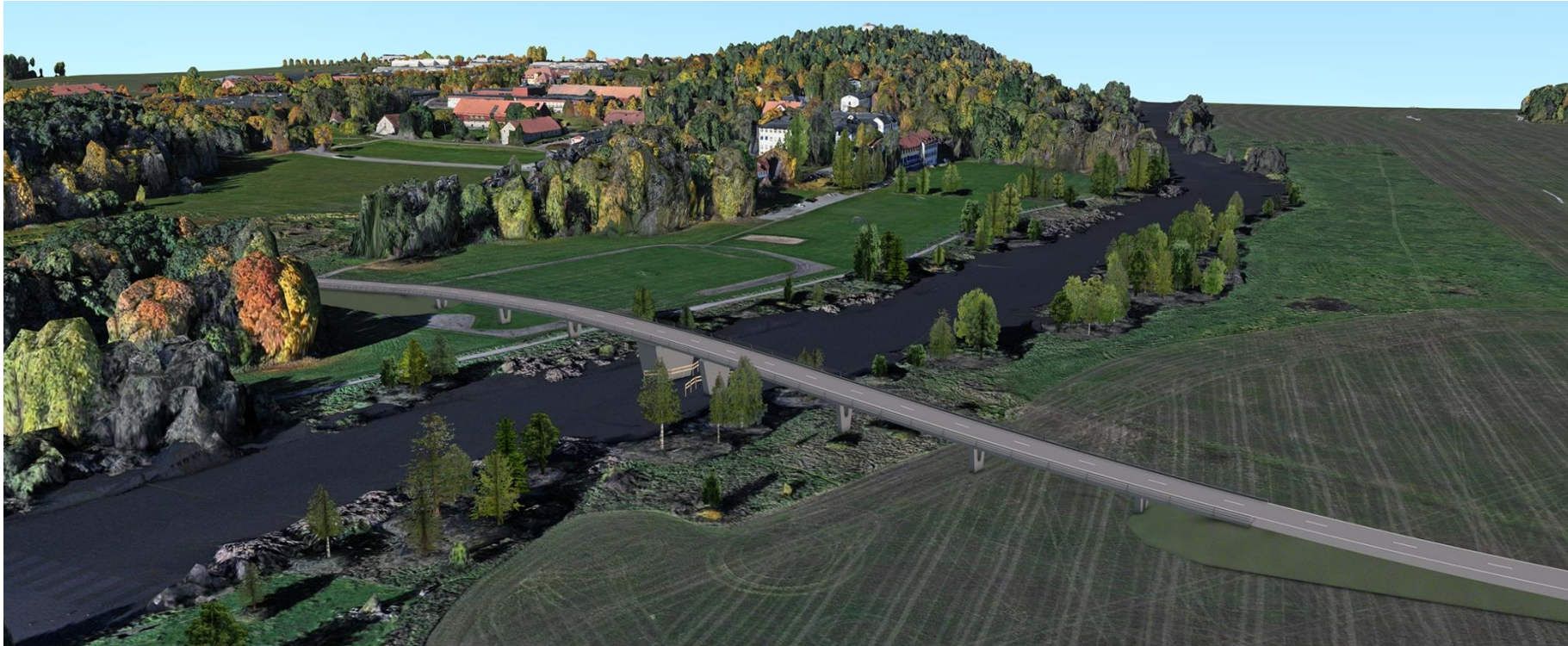
Figur 16. Vägreservat A Syd sett snett ovanifrån från östra sidan om Fyrisån.
