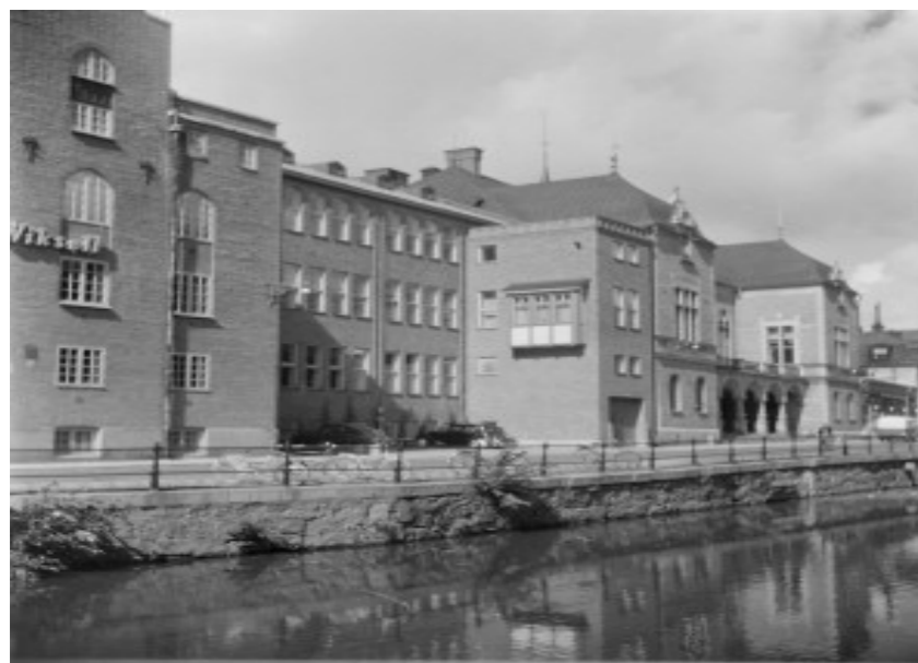
Fasad mot Västra Ågatan innan glasfasaden byggs ut, datum okänt
